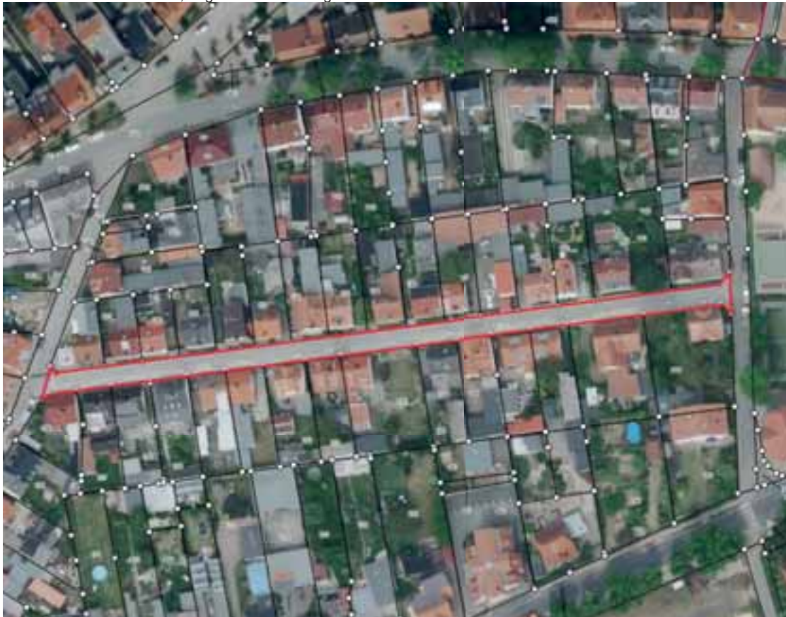
Luftbild aus ARCHIKART, Lage der Straße rot gekennzeichnet
