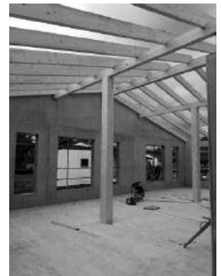
Einbau der Dachverschalung und Abdichtung der Dachfläche Das Gebäude ist regendicht.
