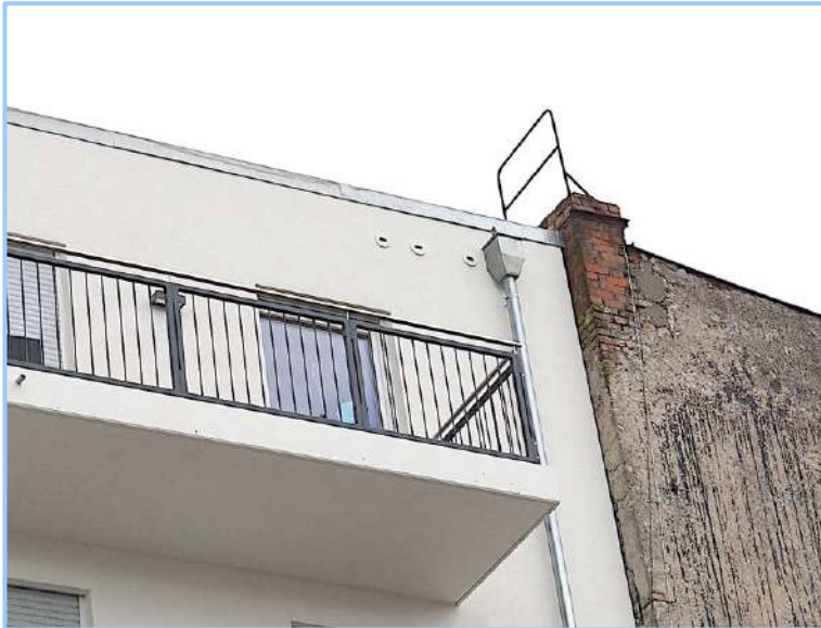
Abb. 26: Integration von einem Mauerseglerkasten 17A, dreifach in einen Neubau. Tino-Schwierzina- Str. 5 in Berlin-Heinersdorf, 2021.
