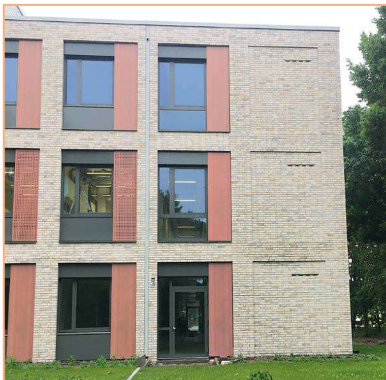
Abb. 25: Integration von Fledermaus- verstecken (Fledermauseinlaufblende 1FE) in das Gerty-Cory-Haus, Deutsches Institut für Ernährungs- forschung in Potsdam-Rehbrücke (Foto: DIfE 2021).
