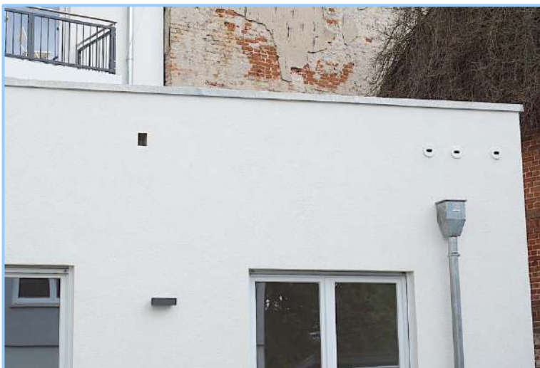
Abb. 27: Integration von einem Mauersegler- kasten 17A, dreifach und einer Halbhöhle 1HE für Hausrotschwänze in einen Neubau. Tino-Schwierzina- Str. 5 in Berlin-Heinersdorf, 2021.
