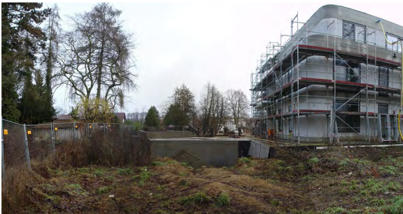
Abb. 11 Blick aus dem Plangebiet nach Osten auf die Tiefgaragen der unmittelbar benachbart zum Plangebiet entstehenden Wohnanlage © Steffen Pfrogner 24.01.2022
