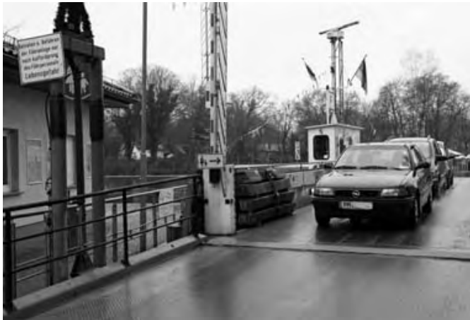
Deutlich sichtbar die Verlängerungen der Hydraulikstempel (dunkle Teile) und die Schwellen als Ballast links in Höhe des ersten Fahrzeugs. Foto: W. Post
