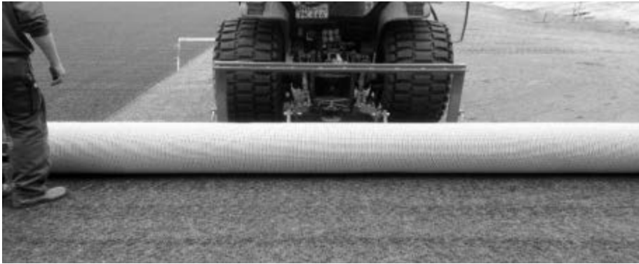
Der Hybridrasen muss in einem aufwendigen Verfahren verlegt werden
