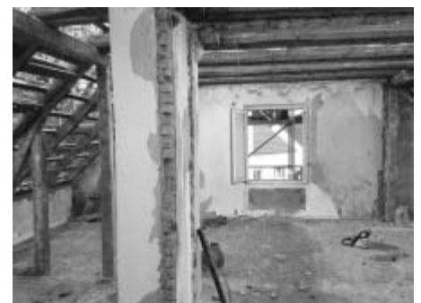
Die Sanierung war eine Herausforderung
