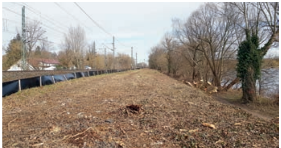
Kahlschlag für die neue, barrierefreie Fuß- und Radwegbrücke Foto: Marina Katzer
