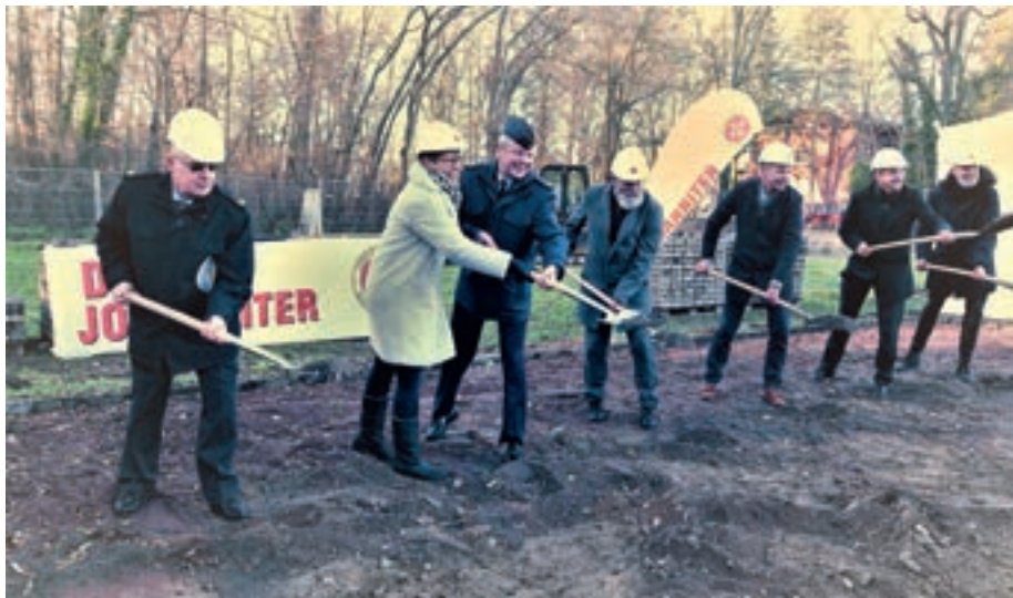
Mit dem ersten Spatenstich beginnen die Bauarbeiten. General Erich Pfeffer, Bürgermeisterin Kerstin Hoppe, Oberst Detlefsen, Wolfgang Blasig und Ralf Boost (v. li.) Foto: Jürgen Schiebert
