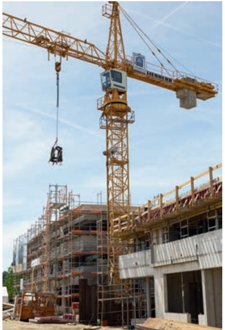
Die Krone zum Richtfest schwebt über dem 1. Bauabschnitt
