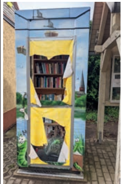
Doppelte Zerstörungswut: Die bereits notdürftig reparierte Bücherzelle wurde abermals demoliert Fotos (2): Regina Petschke
