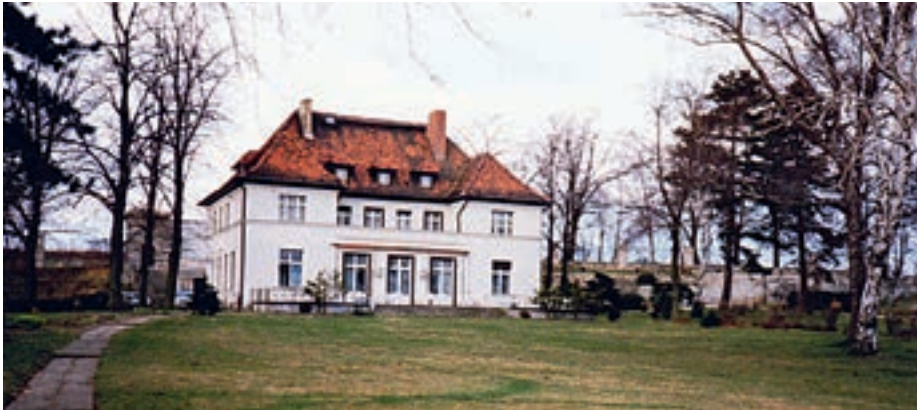
Die „Villa Berglas“ in Petzow wurde von 1955 bis 1990 vom Schriftstellerverband der DDR gepachtet Foto: Dirk Schulze (Archiv)
