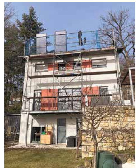
Unsere Baustelle bei der Installation der Photovoltaikanlage mit Speicherbatterien Foto: Mareike Bergner
