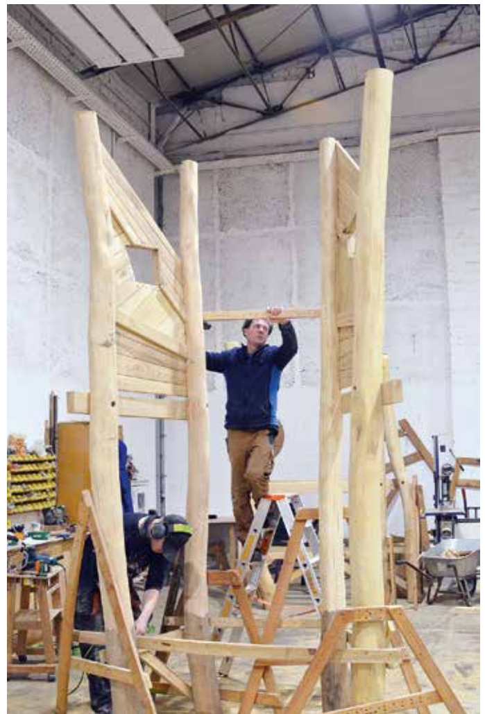
Andreas Schramm – in luftiger Höhe – und Robert Richter bei der Montage eines Klettergerüsts
