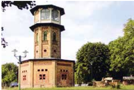
Turm des Glindower Ziegeleimuseums
