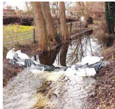
Zur Sicherung des natürlich aufgestauten Wassers dienen Sandsäcke am Abfluss des Sees
