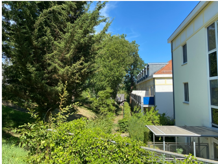
Abbildung 13: Seniorenheim/Freiflächen, Blick von Osten
