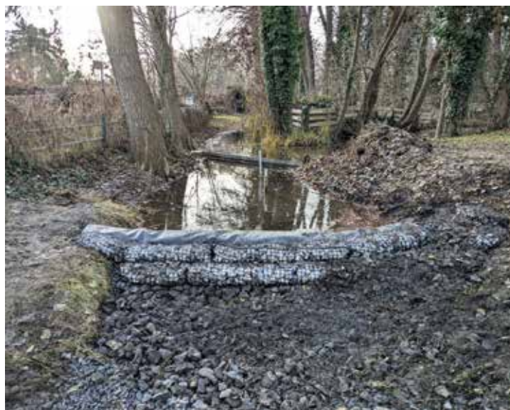
Diese eher unscheinbare Schwelle aus Steinwalzen im Abfluss Richtung Schlosspark und Templiner See bewirkt eine Anhebung des Caputher Seepegels um etwa 20 cm, damit das Moor am südlichen Rand nicht weiter austrocknet Foto: Ernst Huenges
